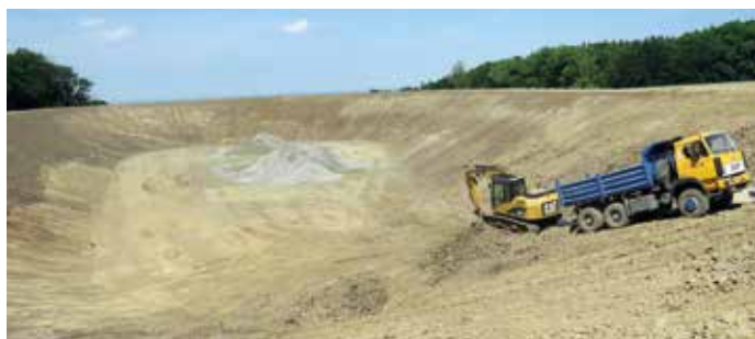
Budoucí hlavní akumuláční nádrž. Foto: PSJ
