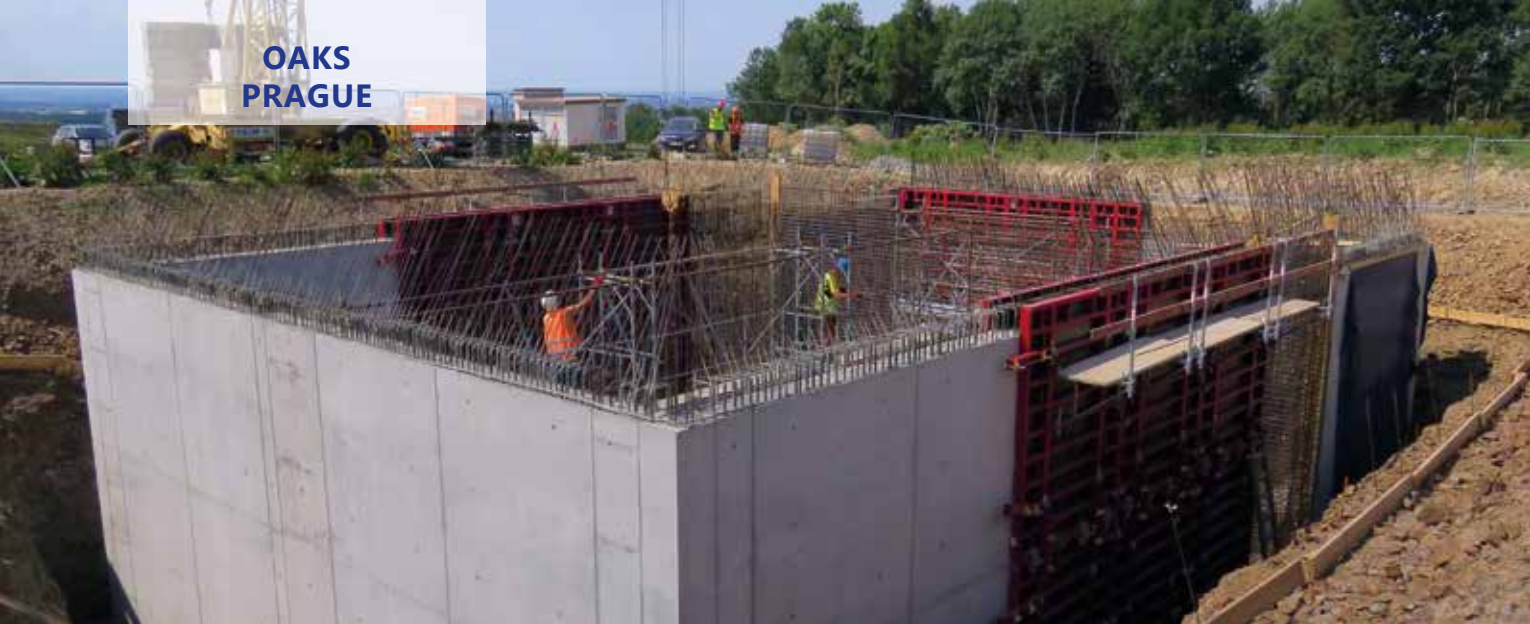
Probíhající stavba čistírny odpadních vod budoucího komplexu Oaks Prague. Foto: PSJ
